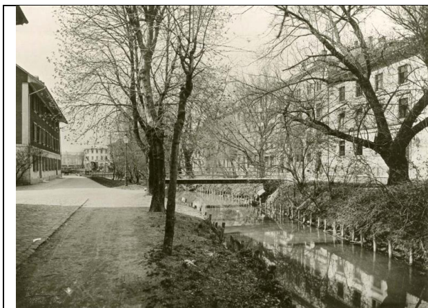
Eulach vor der Eindolung, Technikumsstrasse, um 1900
